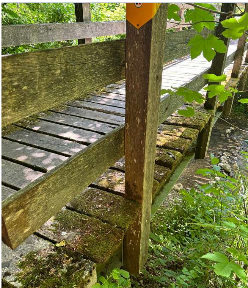
Fussgängerbrücke Eital vor Sanierung
